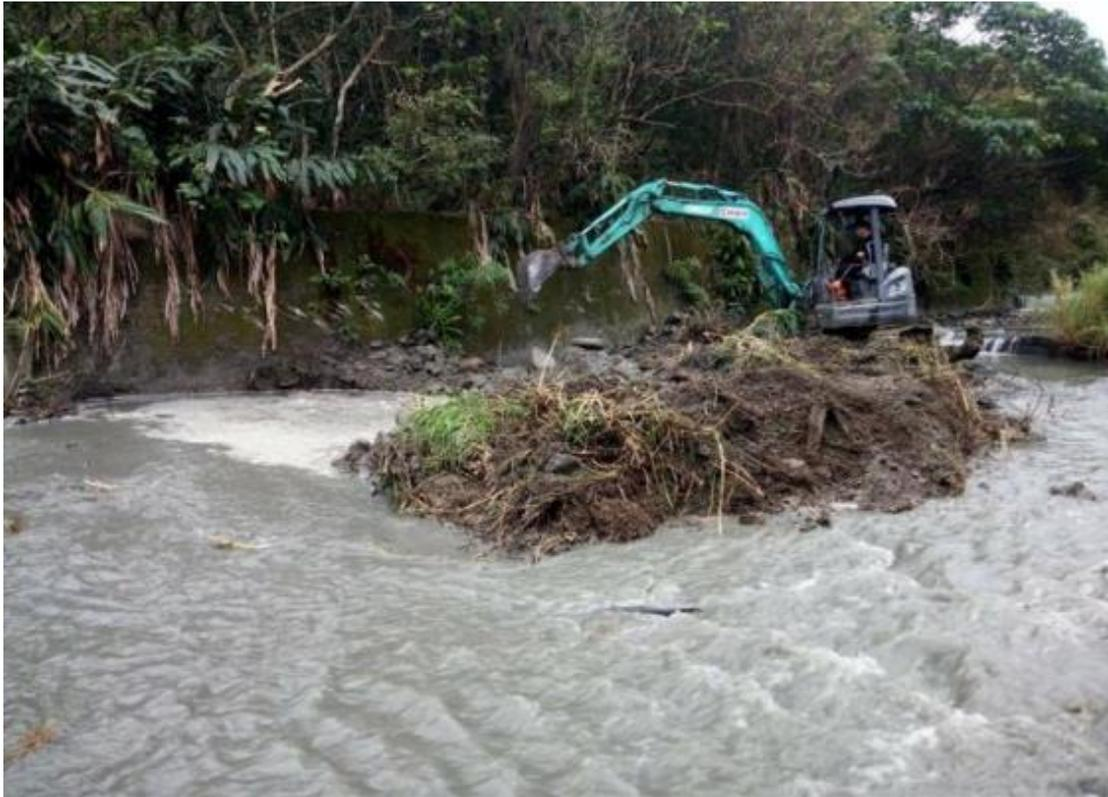
【圖 4、以怪手將水籠前方二公尺處堆積泥砂】
