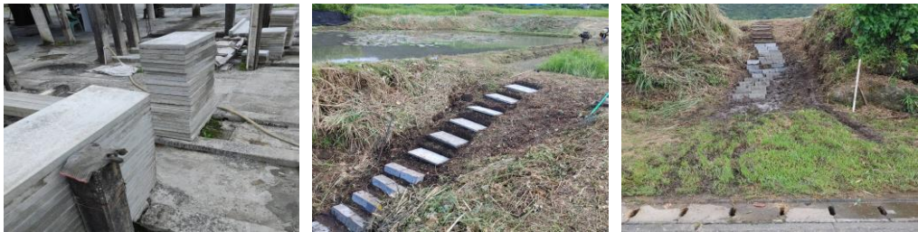
圖 16、濕地階梯鋪設
