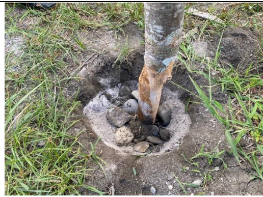
立柱，灰泥中放入石頭讓底部更穩固
