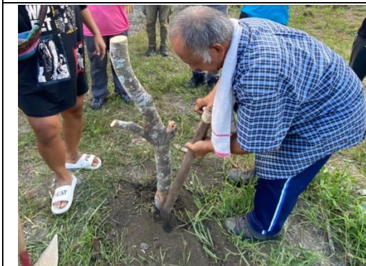
最後覆土完成。隔日基柱十分堅固
