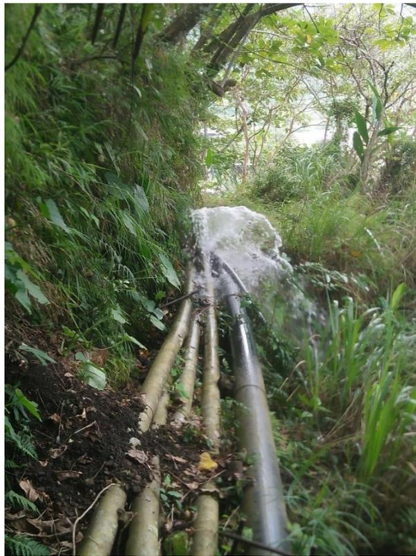
10/25 林班地 PVC 管線於土圳動工時毀損狀況
