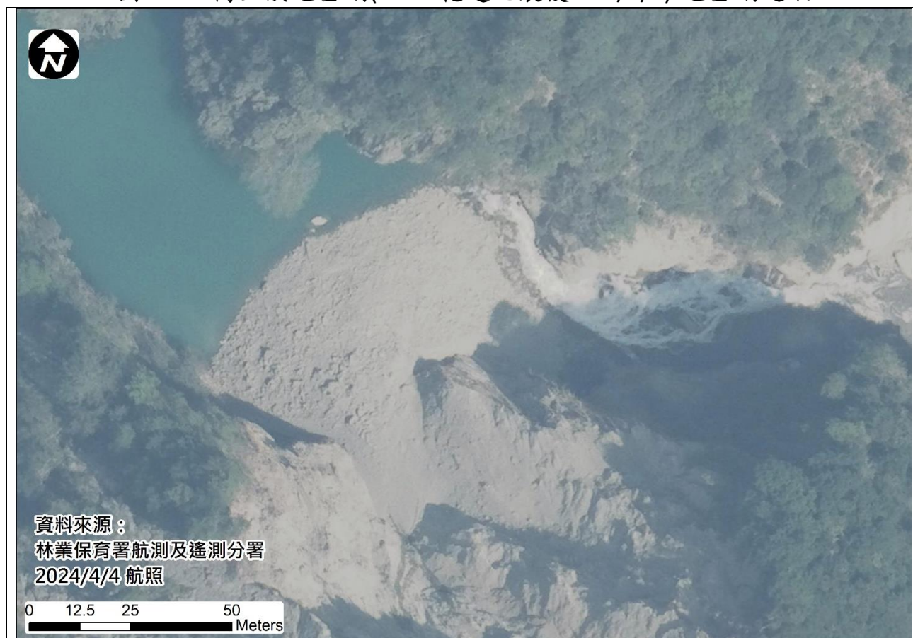
圖 3-10、萬里溪堰塞湖(113/4/4 航照)-堰塞湖已溢流
