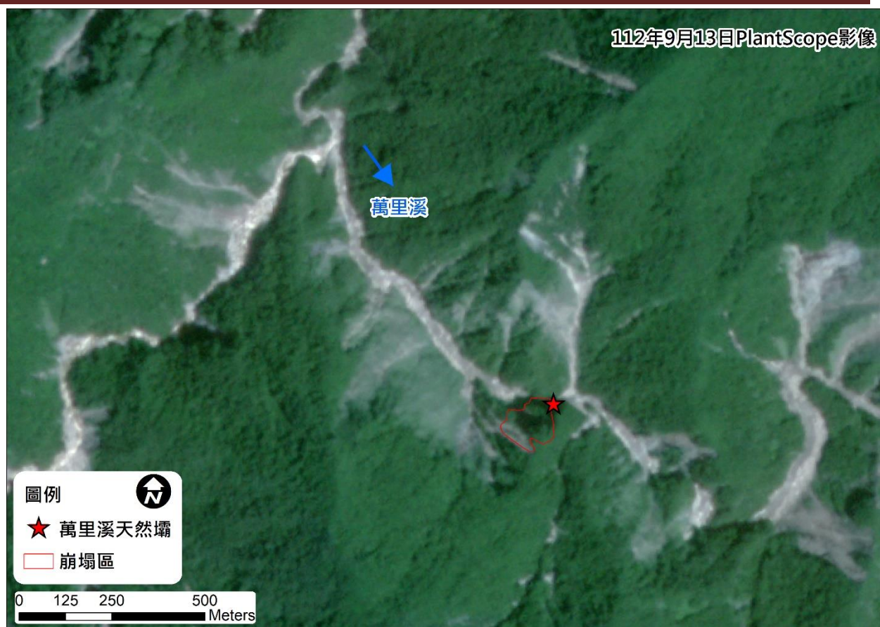
圖 3-3、萬里溪堰塞湖(112/9/13)-右岸邊坡尚穩定
