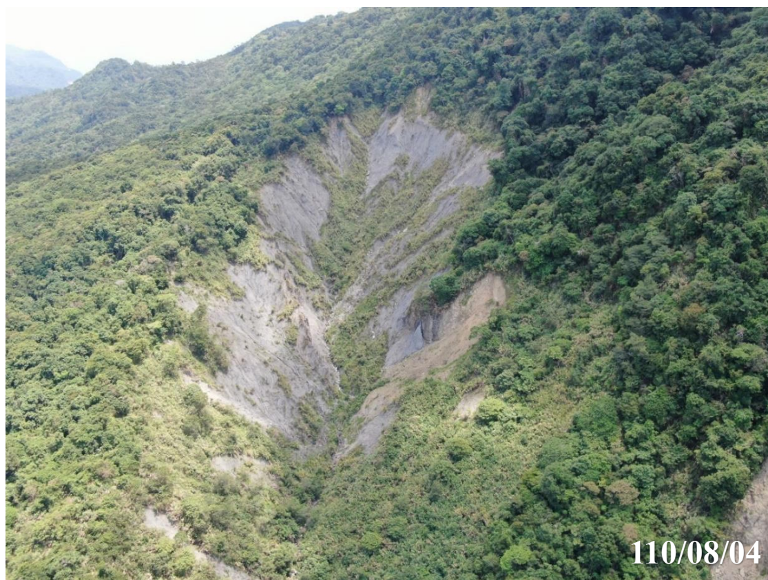
圖 2-2、林田山事業區 154 林班舊有崩塌地坡面裸露照片
