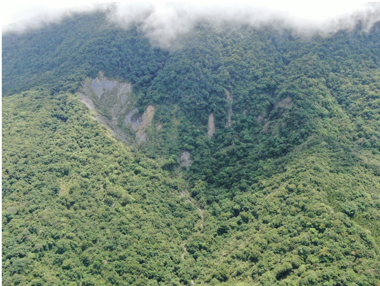
圖 2-25、崩塌地周遭全景(110.08)
