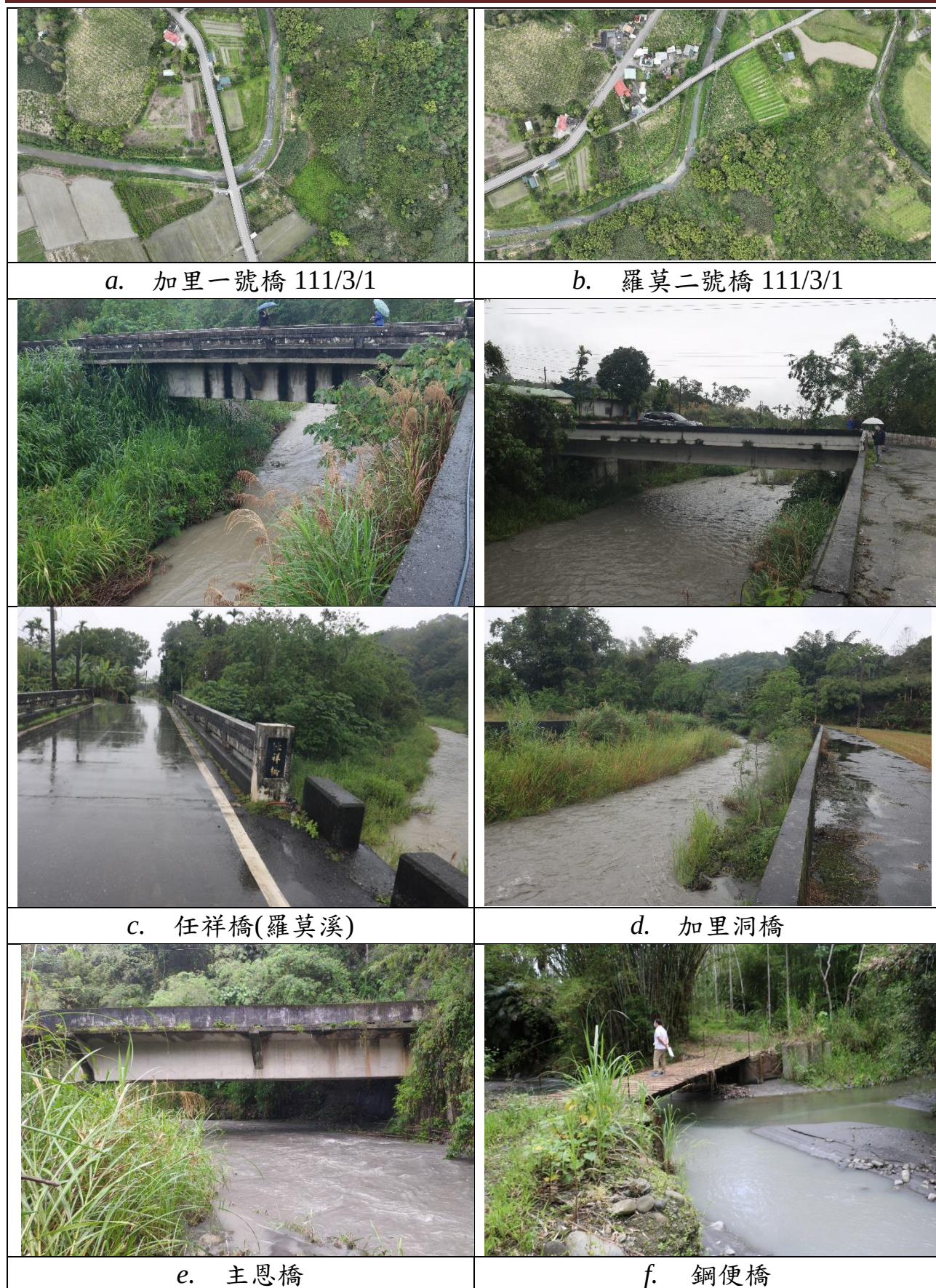
圖 3-7、跨河構造物現場環境照片圖
