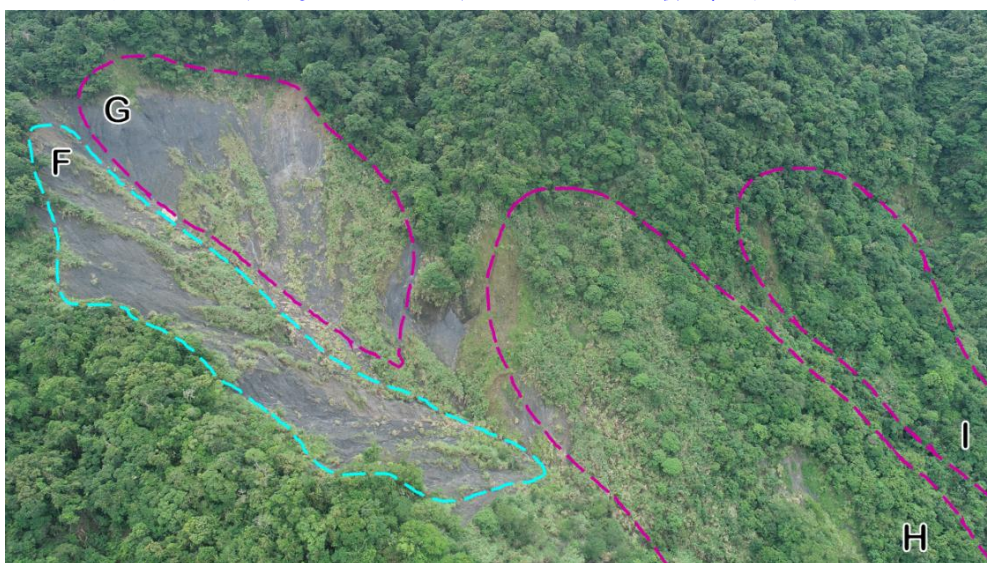
圖 3-34、花蓮縣-光復鄉-D032 坡趾舊有崩塌與判釋滑動體對照圖
