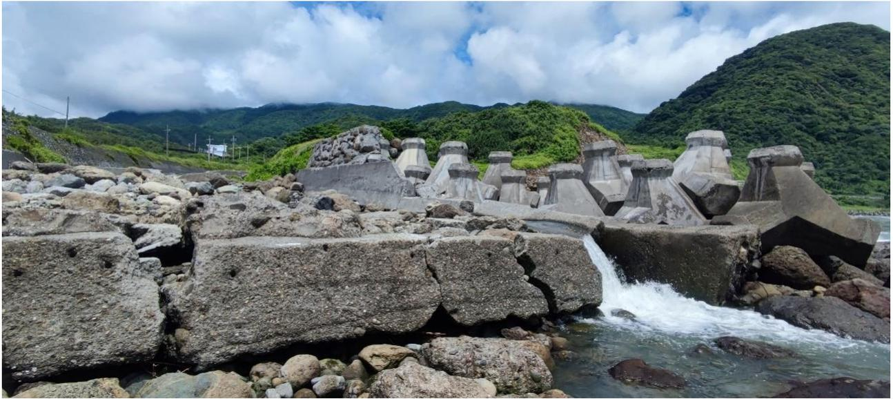
圖 3- 19 河口拆壩近一年半後河口堤壩底部掏空照 2022/06/29 (資料來源：本團隊拍攝)
