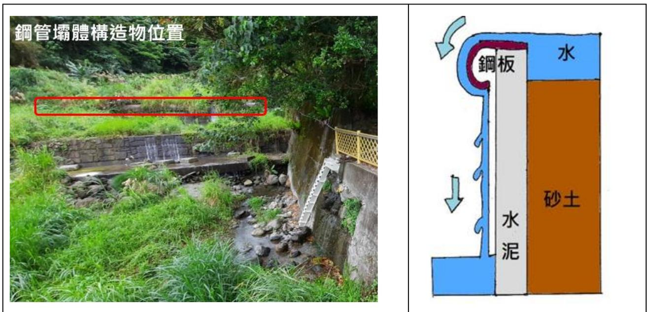
圖 3- 54 大不岸溪及加塹溪上游鋼管壩體結構現況圖及示意圖
