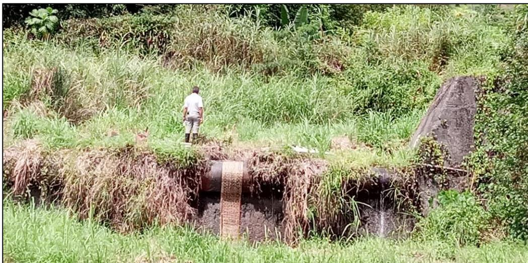
圖 3- 63 鋼管壩軟性結構改善竹編試驗完成近照及遠景圖
