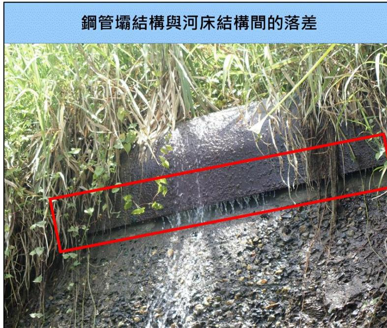
圖 3- 55 鋼管壩結構與河床結構落差
