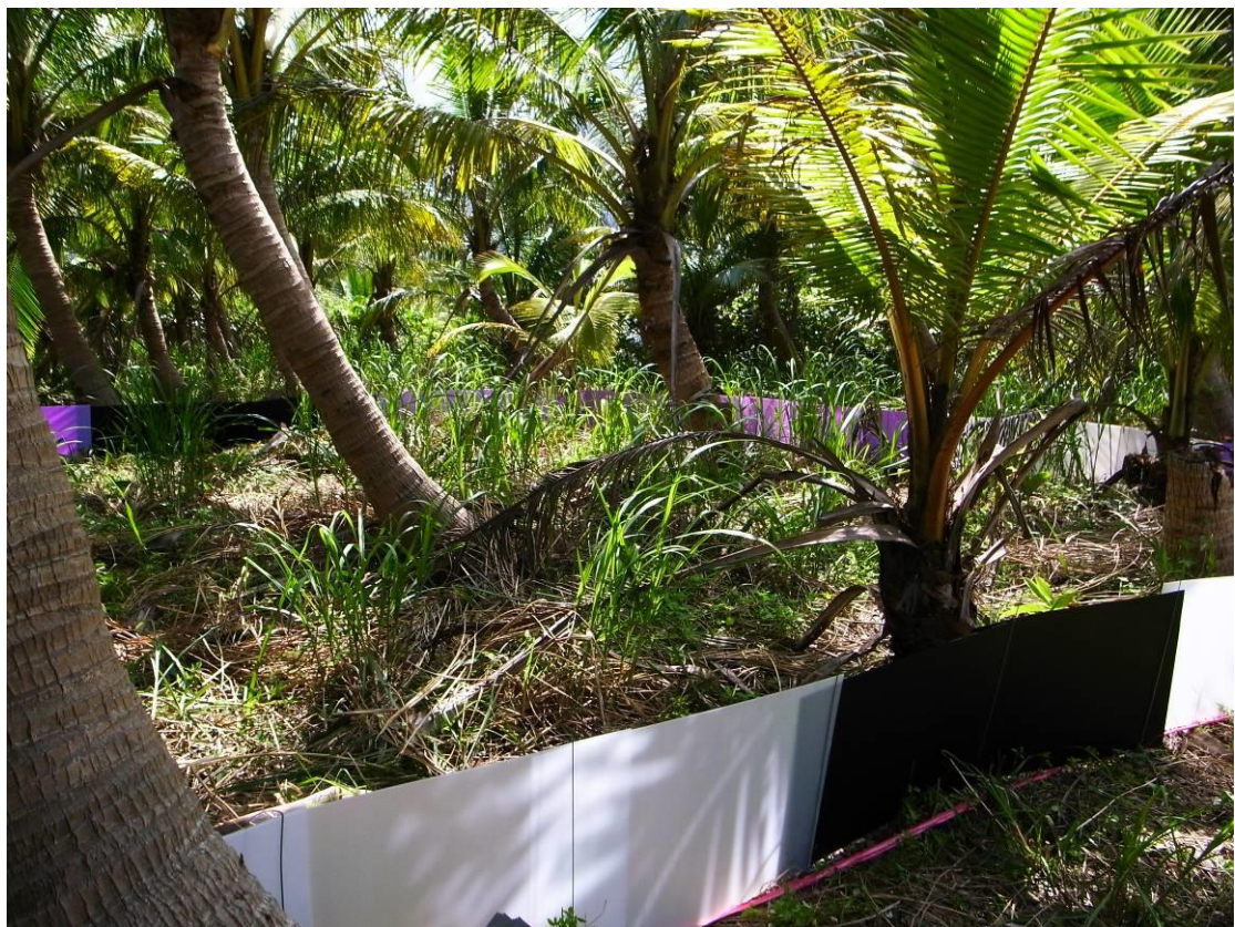
圖 15、檔板圍籬架設完成圖
