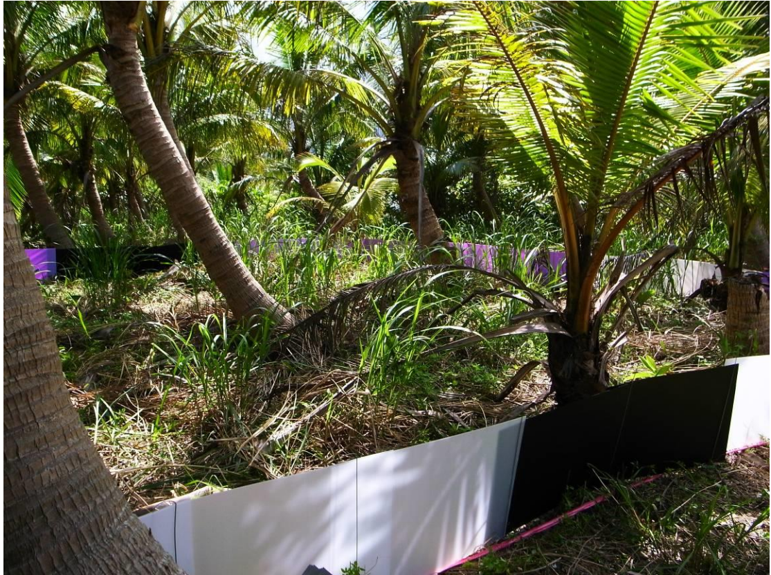
圖 10、檔板圍籬架設完成圖
