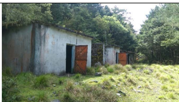
照片 9 2016/06/28~07/01 保護區現地踏查，32K 廢棄彈藥庫。
